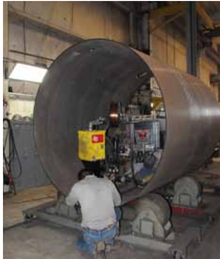
Welding Longitudinal Seam
